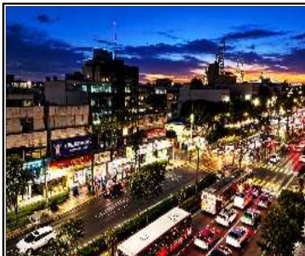
Problemas de suministro eléctrico en Yucatán
